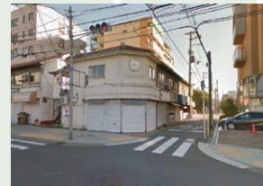
時計がシンボルだった町屋の解体
